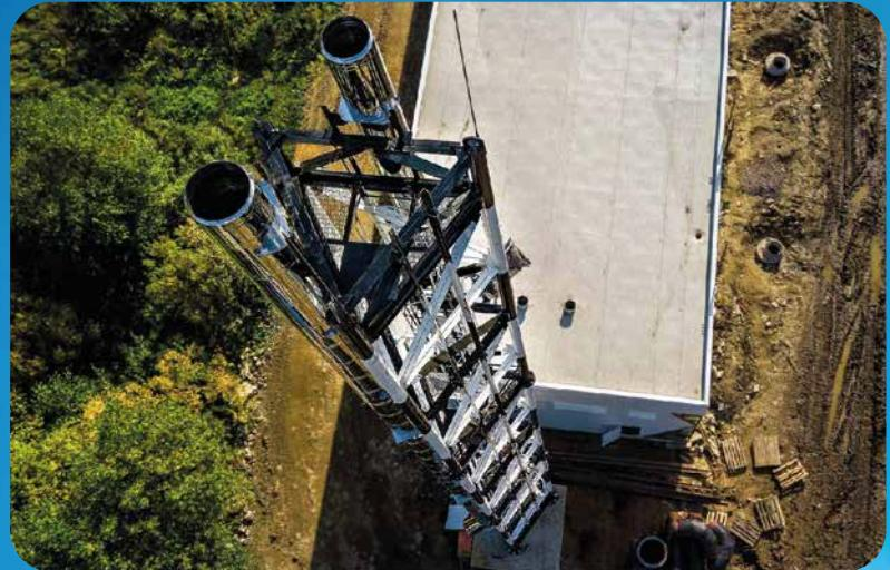
Помимо газоотводящего ствола башня состоит из несущей стальной конструкции, состоящей из трех секций. Каждую секцию мы оснастили двойными ребрами жесткости из металлических уголков — такая защита особенно важна в условиях значительной ветровой нагрузки.
