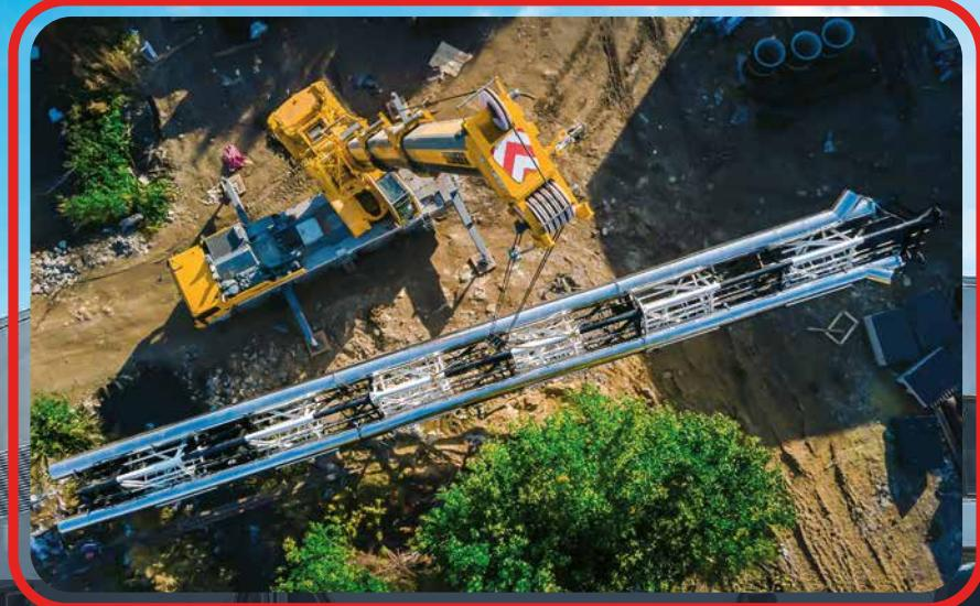
На место возведения каждая секция доставлена отдельно — погрузка на грузовой транспорт производилась с помощью мостовых кранов. Сборка целой башни, подъем и установка опорной вышки произведены за один день.
