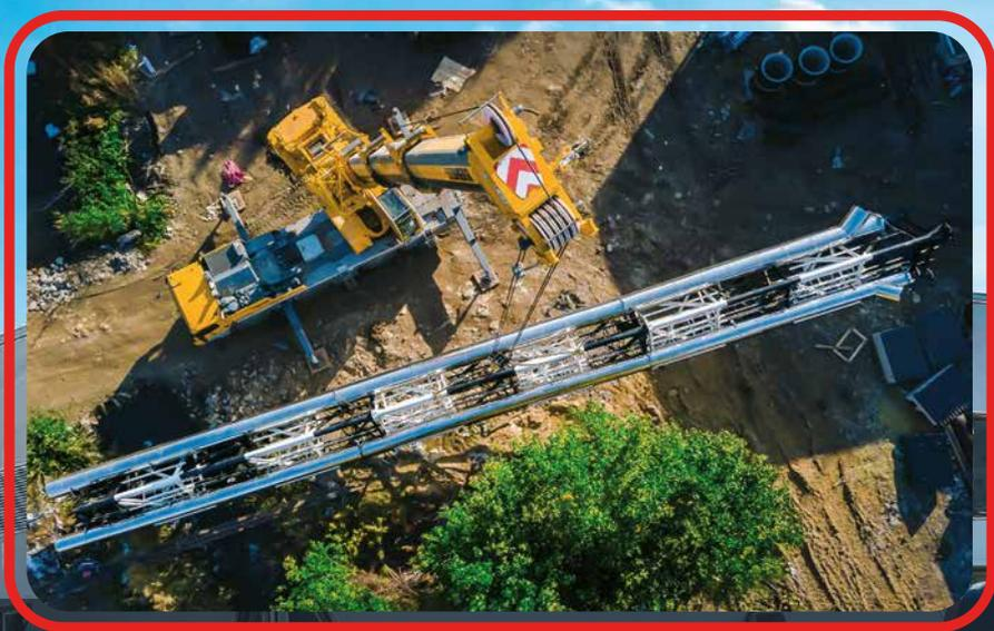
На место возведения каждая секция доставлена отдельно — погрузка на грузовой транспорт производилась с помощью мостовых кранов. Сборка целой башни, подъем и установка опорной вышки произведены за один день.
