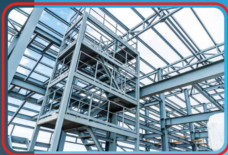
Каркасное здание площадью 48×21 м. Несущим каркасом послужили поперечные рамы из колонн и ферм с шагом 6 м.
